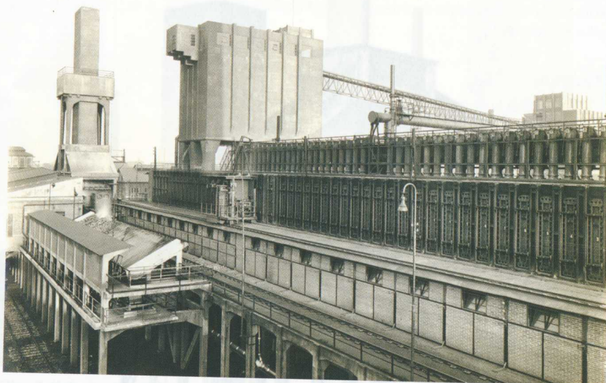
Obr. 3: VII. skupina koksových pecí kolem roku 1930, hasicí věž vlevo (Archiv OKD)
